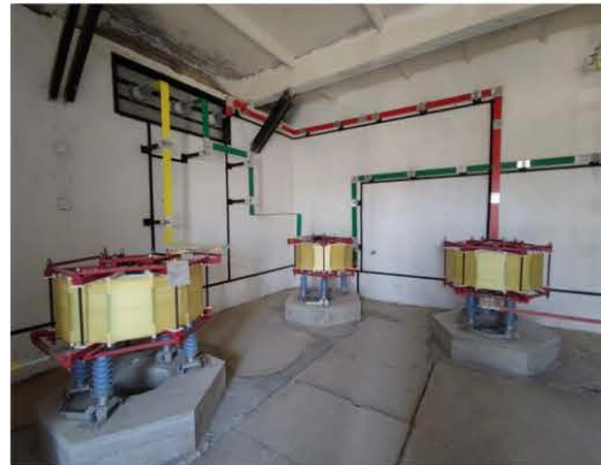
РЕКОНСТРУКЦИЯ ТОКООГРАНИЧИВАЮЩИХ РЕАКТОРОВ ТОР-10КВ ПС-220КВ «БЕЙНЕУ»
