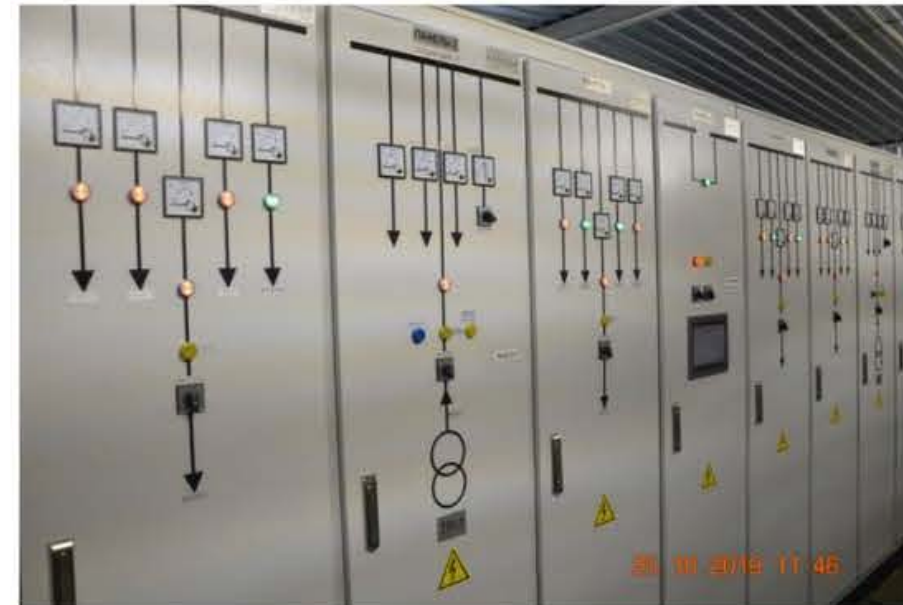
Строительство очистных сооружений для очистки шахтных вод, производительностью 8500 куб.м/сут
