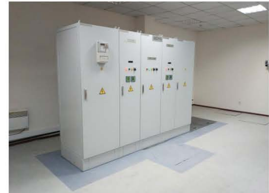
Реконструкция ЩПТ и ЩСН на ПС-500 кВ «Аврора»
