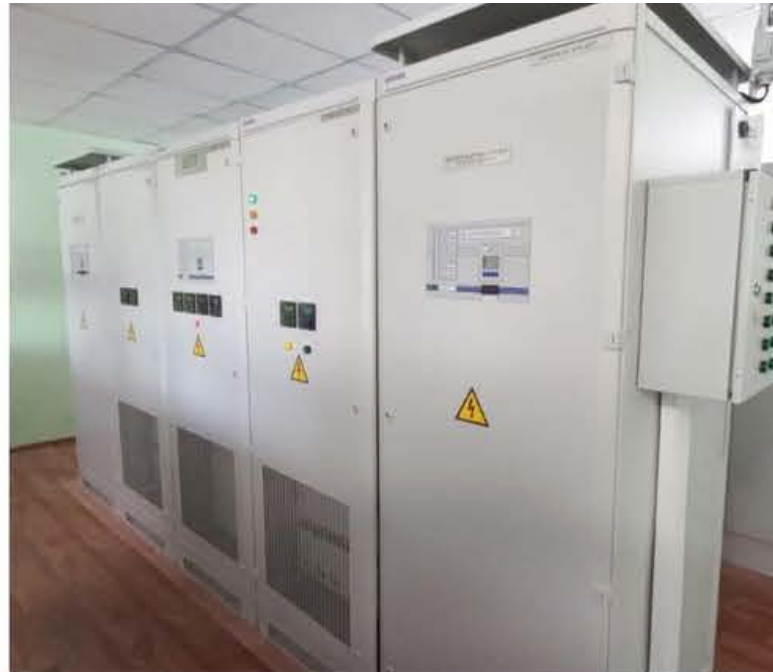
Реконструкция ЩПТ и ЩСН на ПС-220 кВ «Восточная»
