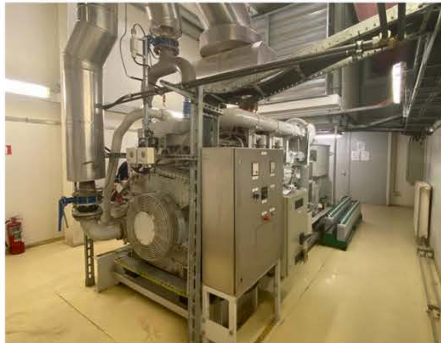
Замена системы управления и автоматизация Аварийных дизельных Генераторов в КПК.
