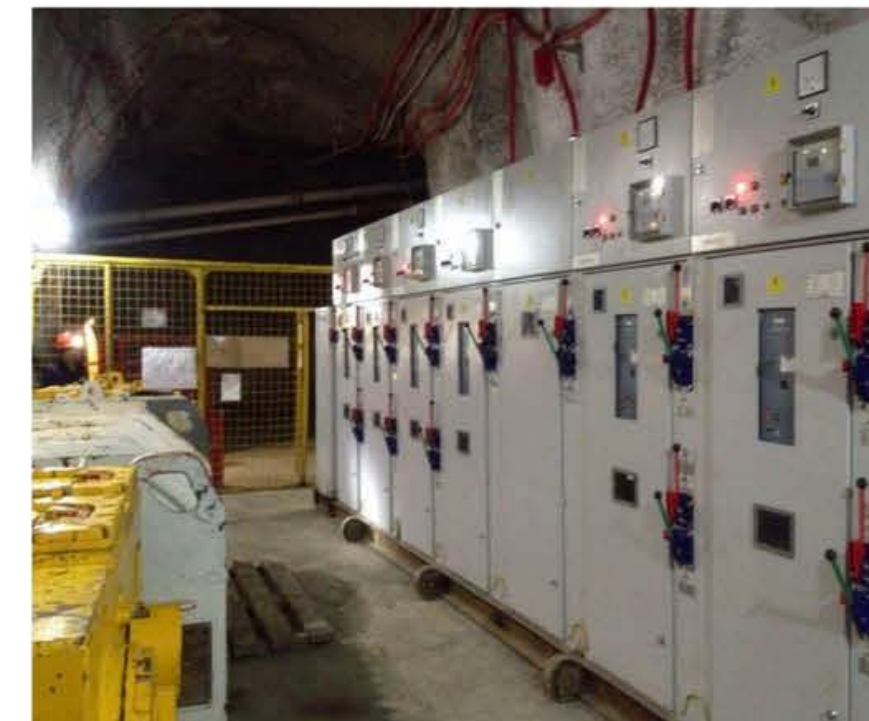
Комплектное распределительное устройство 10 кВ 1250 А для шахты добычи хромовых руд на отметке – 160 м
