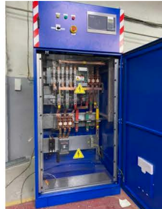
УПП горнорудного исполнения 315 кВт, система мониторинга, автоматического и дистанционного управления.
