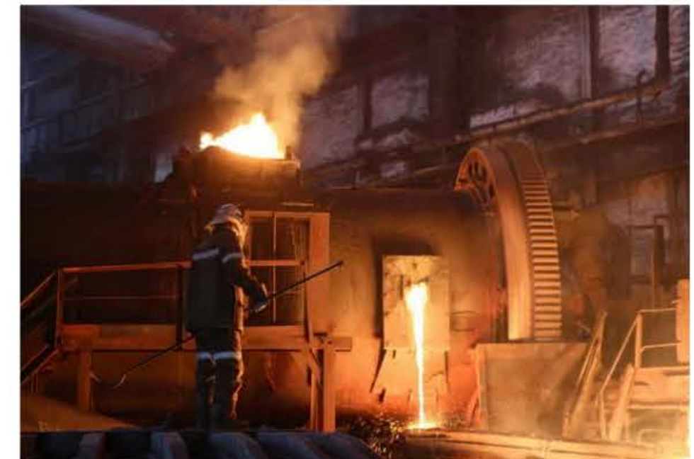
Система автоматизированного управления поворотным механизмом анодной печи на Жезказганском металлургическом заводе
