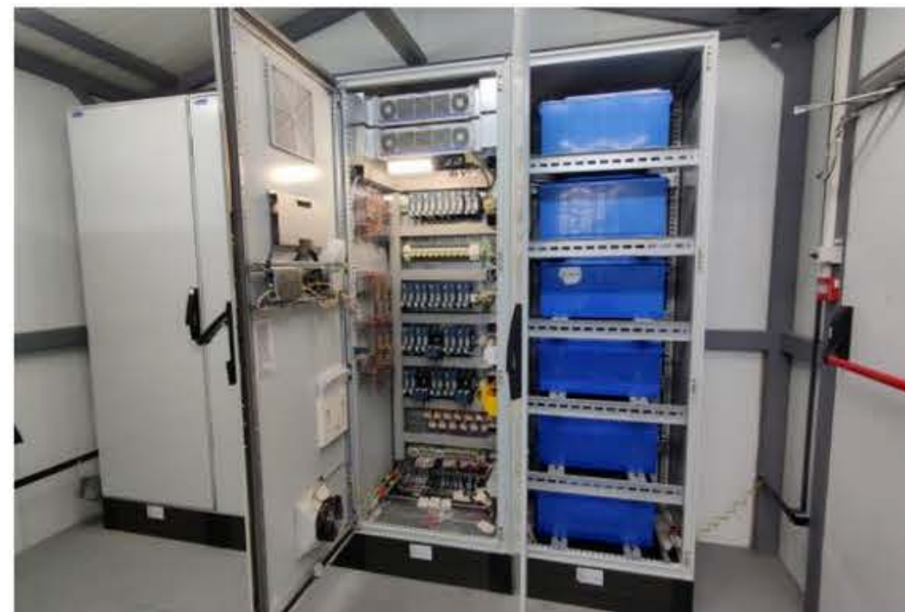
ИЗГОТОВЛЕНИЕ И ПОСТАВКА ЩСН, ШОТ, ШЗТТ, ШЗТН И ДР. НА ВЭС 50 МВт «ЖЕРУЙЫК ЭНЕРГО»
