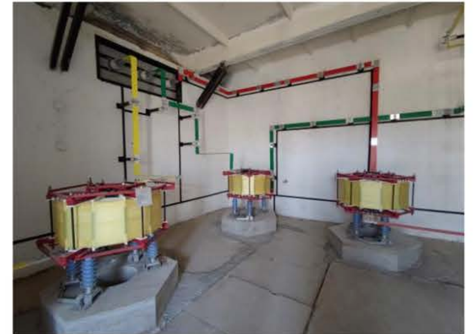
РЕКОНСТРУКЦИЯ ТОКООГРАНИЧИВАЮЩИХ РЕАКТОРОВ ТОР-10КВ ПС-220КВ «БЕЙНЕУ»
